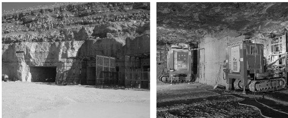
Rys. 9. Kopalnia wapieni Jordans – korytarze udostępniające część podziemną oraz wyrobiska podziemne z maszynami do odstawy bloków (źródło: Albion Stone plc)
