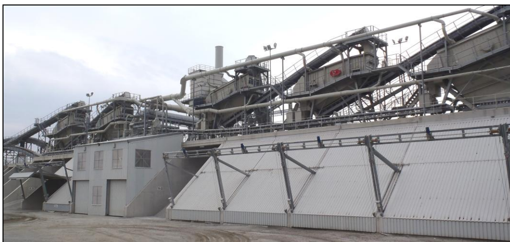
Rys. 3. Hermetyzacja boksów materiałowych i kruszarni III stopnia w Kopalni Wieśnica (zdjęcie od strony wsi Goczałków)
