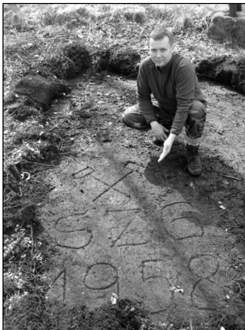
Rys. 1. Skrót nazwy „Sudeckie Zakłady Górnicze” utrwalony na powierzchni żelbetowej płyty zamykającej zlikwidowany szyb kopalni „Gierczyn” (prezentuje autor)
