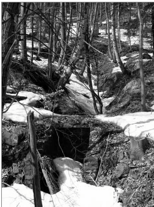
Rys. 5. Zawalony wlot górnej sztolni kopalni „Czarnów” Fig. 5. Caved in entry of upper adit of mine ”Czarnów”
