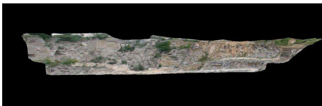
Rys. 10. Widok ściany wyrobiska w formie modelu numerycznego z teksturą Fig. 10. View on the quarry wall – numerical model with a texture
