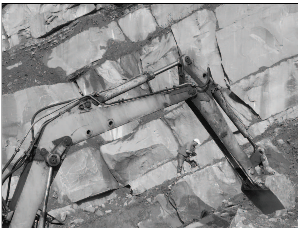
Rys. 6. Ściana kamieniołomu Tenczyn–Lubień II Fig. 6. Wall of the Tenczyn–Lubień II quarry
