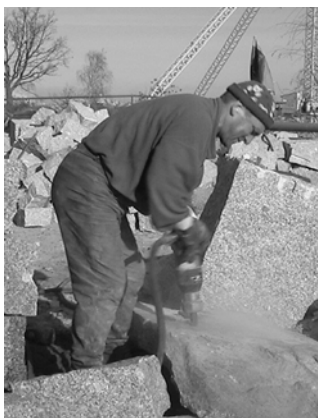
Rys. 1. Obróbka bloków skalnych Fig. 1. Wedging of stone blocks
